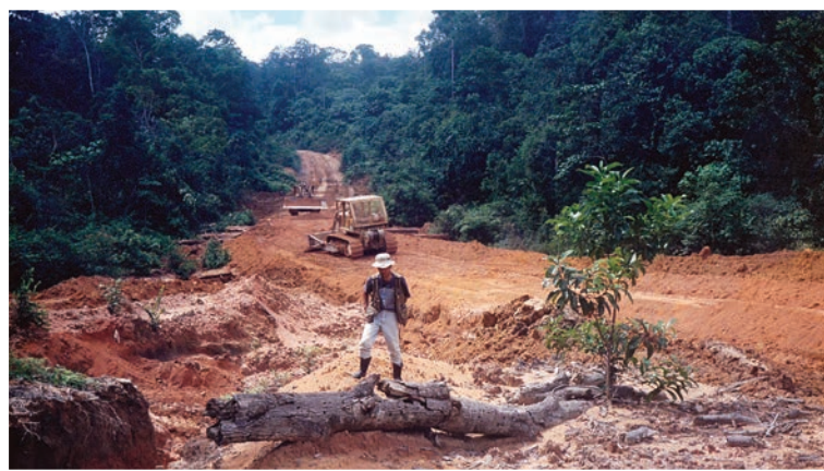
Бульдозеры расчищают недавно построенную дорогу в глубине джунглей Центрального Калимантана, Индонезия.
