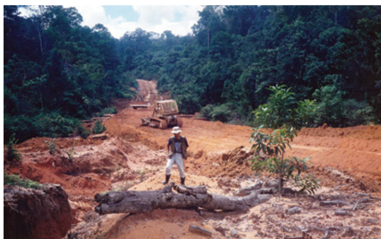
インドネシアのボルネオ島中部でジャングル奥深くに作られたばかりの道路を整備するブルドーザー
